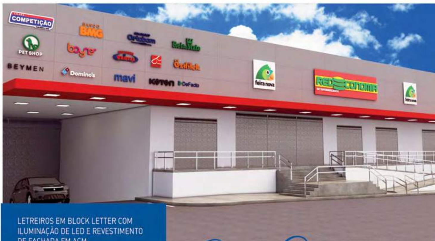
LETREIROS EM BLOCK LETTER COM ILUMINAÇÃO DE LED E REVESTIMENTO DE FACHADA EM ACM.
